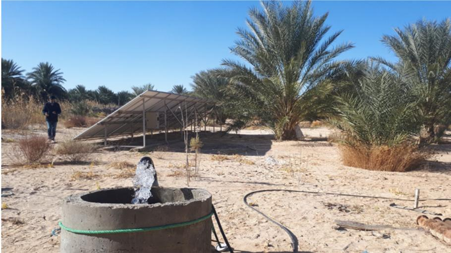
Le système d'irrigation par pompage solaire fonctionne au moyen de panneaux photovoltaïques. Grâce à l'énergie générée par ces panneaux, la pompe s'active et puise l'eau disponible dans les nappes phréatiques.
