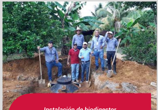
Instalación de biodigestor. Fuente: Fotografía de personal de Fundación Horizontes de Amistad. Septiembre 2021.
